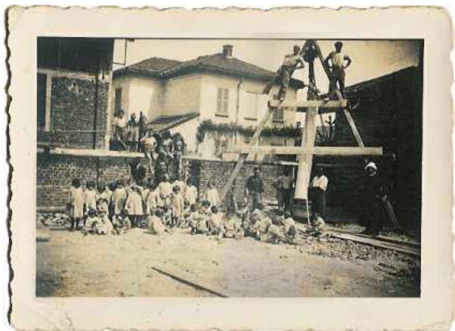
bambini "dell'Asilo" in visita ai lavori
