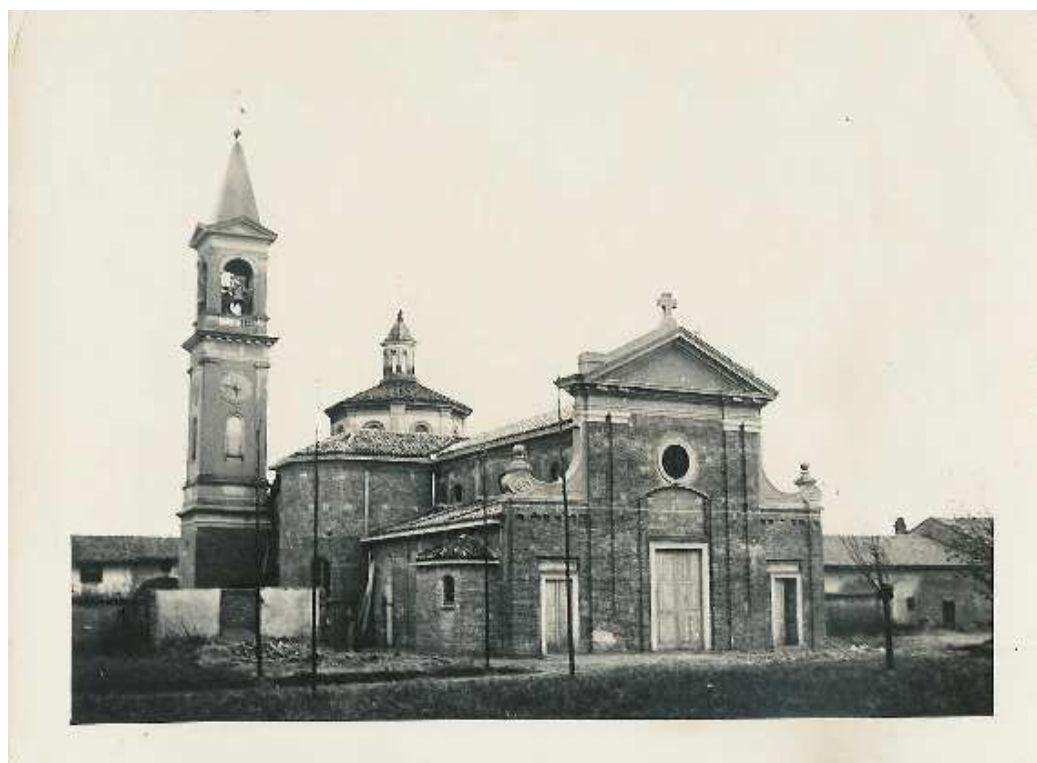
la chiesa ultimata nella sua struttura
