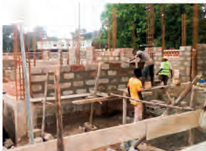
Il cantiere del pronto soccorso a Tanguièta
