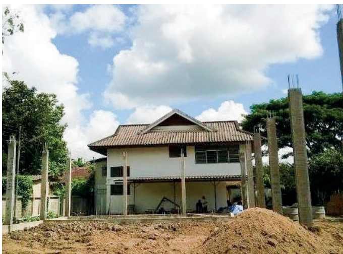
Il centro polifunzionale del Pime in costruzione
