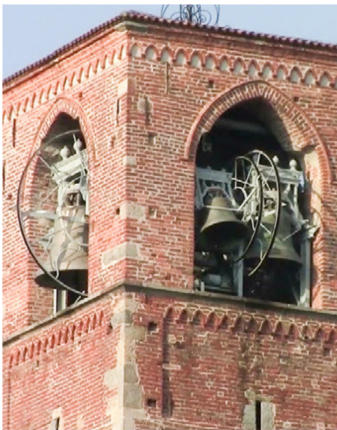
La cella campanaria della torre del Barbarossa
