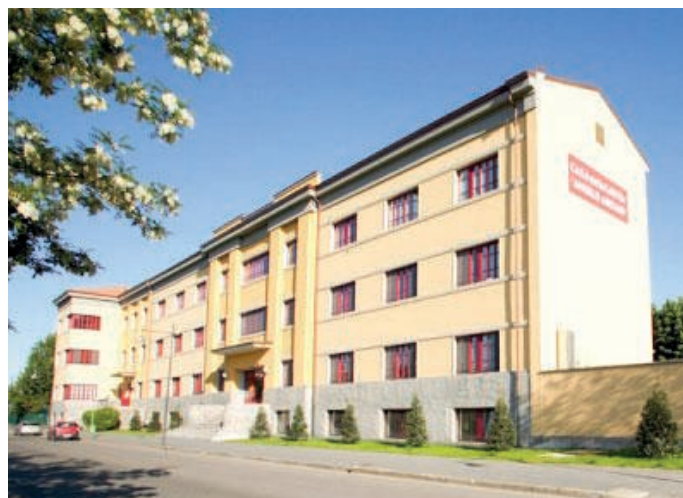
La casa della carità di Milano
