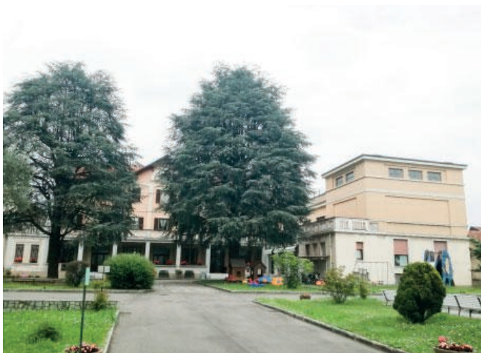
Il complesso di via Montello dell'istituto Pozzi
